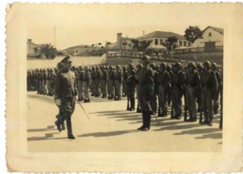
FIG. 17 Fotografia do Quartel em funcionamento.
