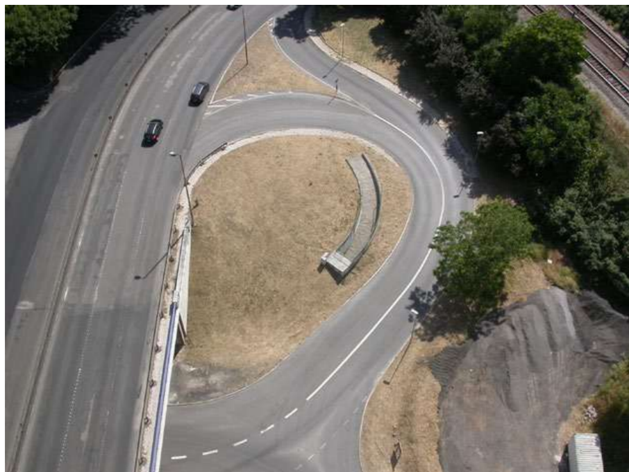
FIG. 01 Vista do Aqueduto das Águas Livres sobre os acessos rodoviários e a linha ferroviária do vale de Alcântara. Registo realizado no âmbito do projecto Outra Lisboa - viagens num espaço urbano maior , cuja programação final integrou a edição de 2016 da Trienal de Arquitectura de Lisboa.
